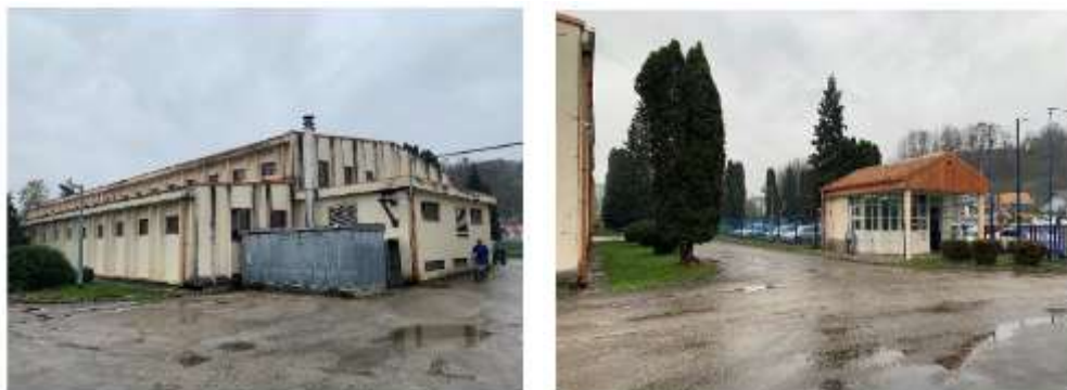
Foto: trafostanica sa kotlovnicom (lijevo), portirnica (desno)
